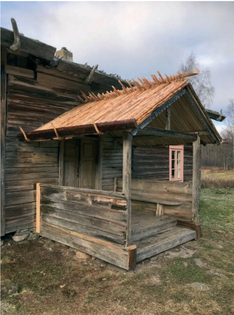
Murtovaaran päärakennuksen uusittu sisäänkäynti.
