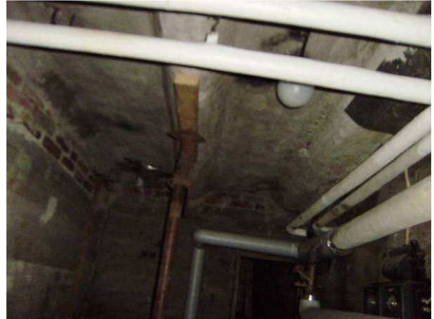
Kellarissa oli myös asennettu teräksisiä holvitukia.
