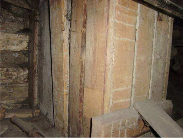
Kellarin betonirakenteisiin on jätetty osittain muottilaudat paikalleen.
