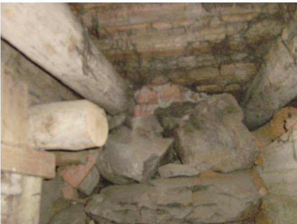
Osa perustuksista on tehty latomalla kiviä ja tiiliä.
