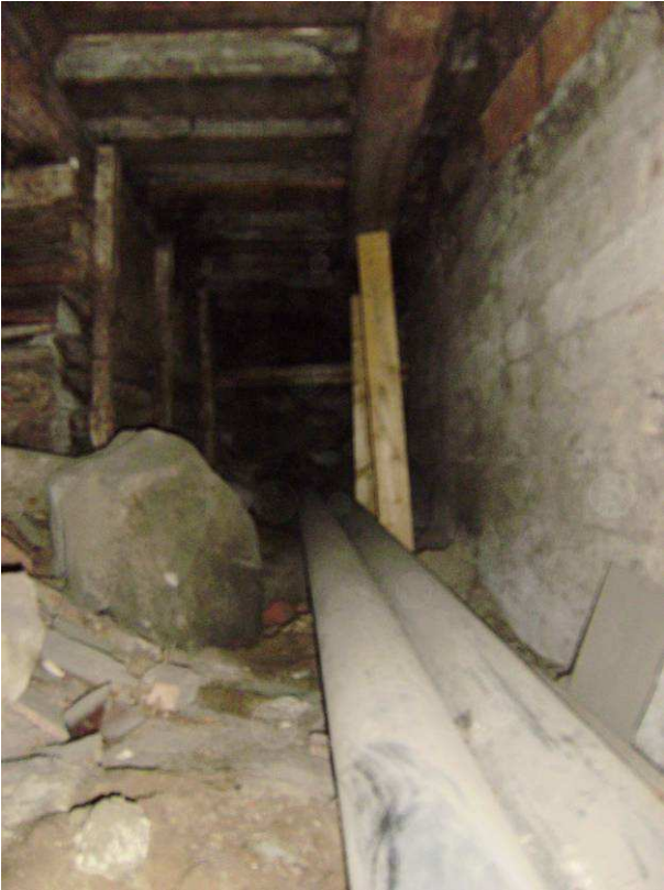
Väliaikaisesti tuettu palkki 15
